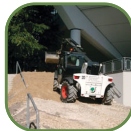
Bau der Rampe
