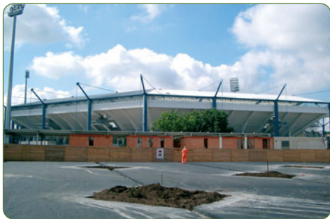
Das Stadion in der Umbauphase
