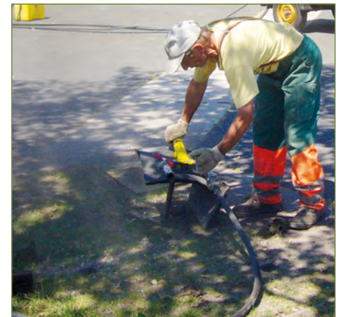
Bodenbelüftung mit der Lanze
